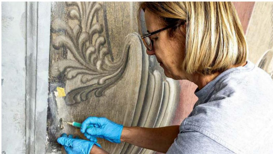
Arbeiten an der Fassade: Hohlräume im Spannungsbereich zwischen den Fenstern werden aufgefüllt, dabei kommen Spritzen zum Einsatz.
